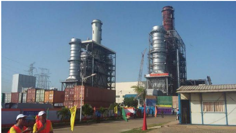
SUNON-ASOGLI POWER PLANT
